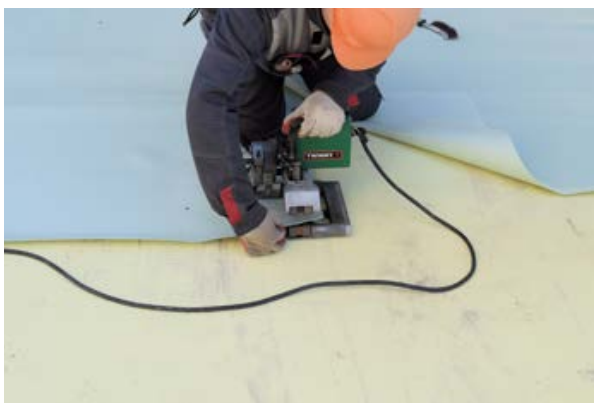
Рис. 11. Сварка полотен текстурированной мембраны (2-го слоя) при помощи автоматического оборудования, позволяющего создать двойной шов с проверочным каналом
