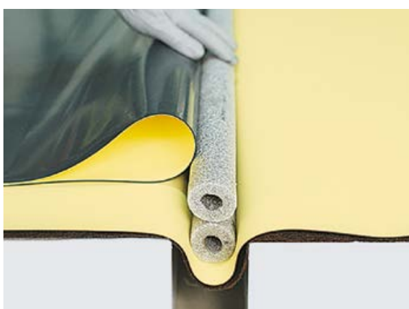
Рис. 6. Монтаж гидроизоляционной мембраны в месте расположения деформационных швов
