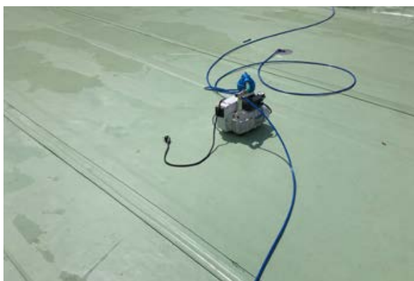
Рис. 23. Подключение к вакуумному насосу по 2-ой схеме
