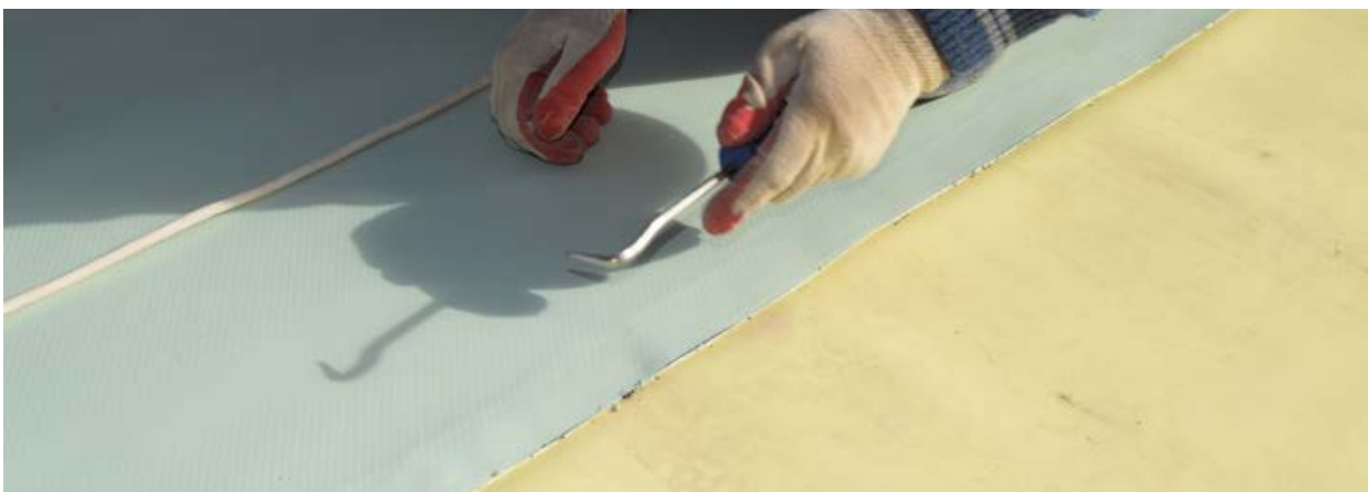
Рис. 19. Проверка качества сварного шва с помощью пробника
