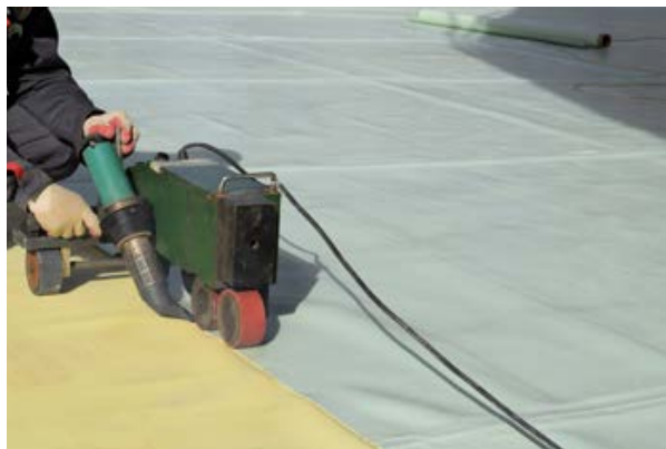
Рис. 14. Сварка автоматическим сварочным оборудованием LEISTER™ Varimat 1-го и 2-го слоев гидроизоляционных полимерных мембран
