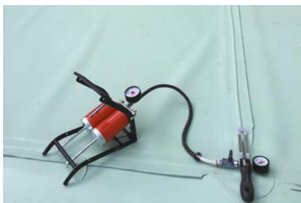
Рис. 12. Сварка полотен текстурированной мембраны (2-го слоя) при помощи автоматического оборудования и проверка герметичности двойного шва
