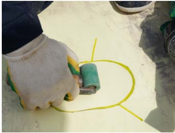
Рис. 9. Выполнение Т-образных пересечений полотен
