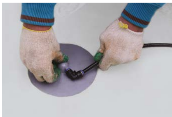
Рис. 21. Соединение углового инъекционного штуцера и трубки
