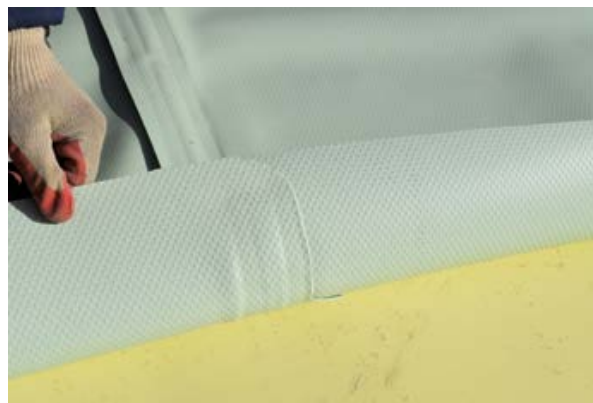
Рис. 13. Срезка свободного края текстурированной мембраны (2-го слоя)
