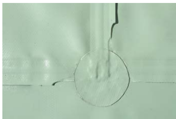
Рис. 12. Сварка полотен текстурированной мембраны (2-го слоя) при помощи автоматического оборудования и проверка герметичности двойного шва
