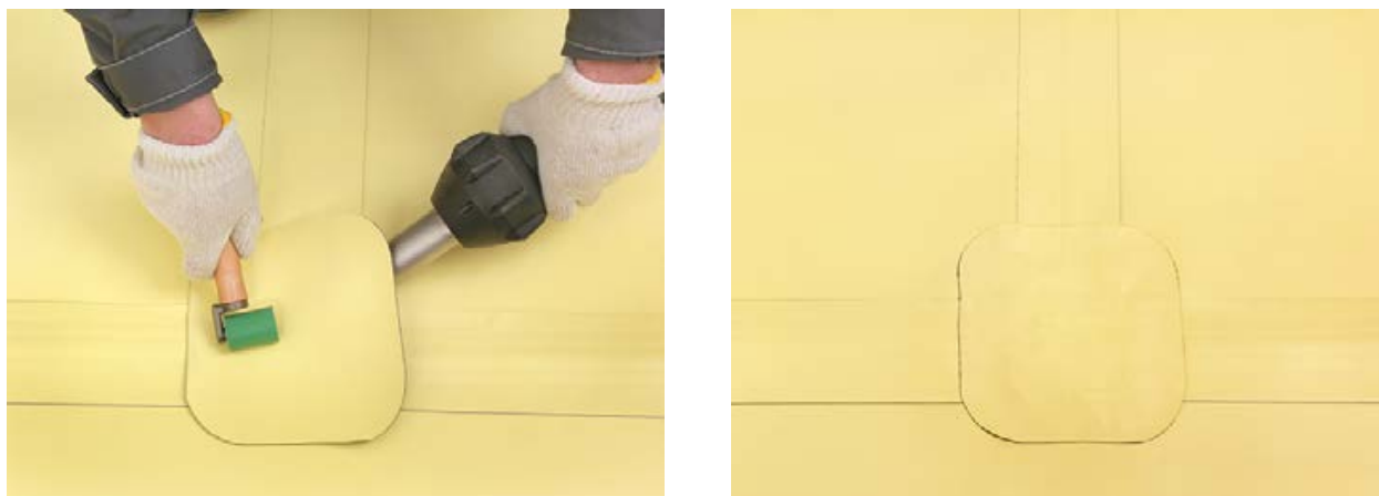
Рис. 8. Выполнение Т-образных пересечений полотен
