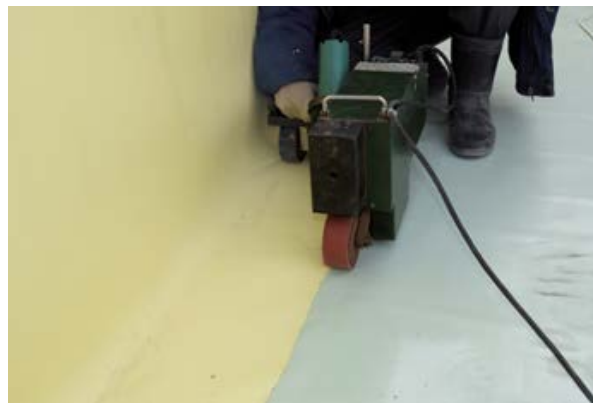
Рис. 14. Сварка автоматическим сварочным оборудованием LEISTER™ Varimat 1-го и 2-го слоев гидроизоляционных полимерных мембран
