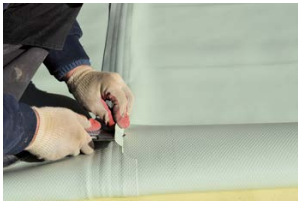
Рис. 13. Срезка свободного края текстурированной мембраны (2-го слоя)
